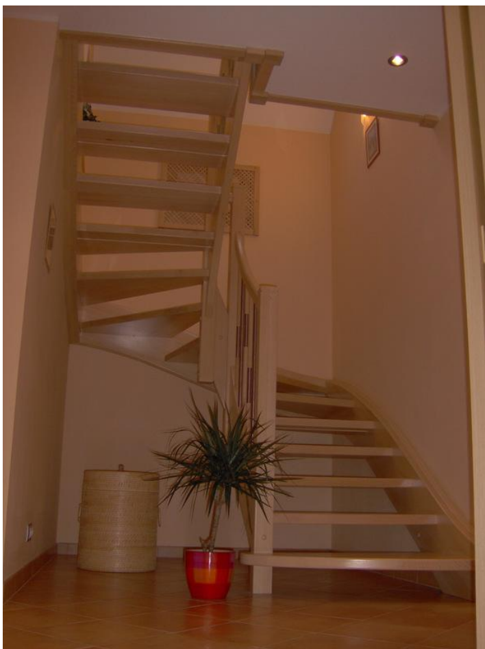
Obr. 6 – Točité dřevěné schodiště ( www.truhlarstvinovaksro.cz )
