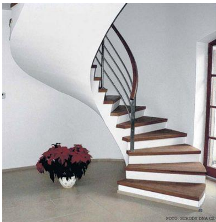
Obr. 7 – Betonové točité schodiště ( www.bydleni.idens.cz )
